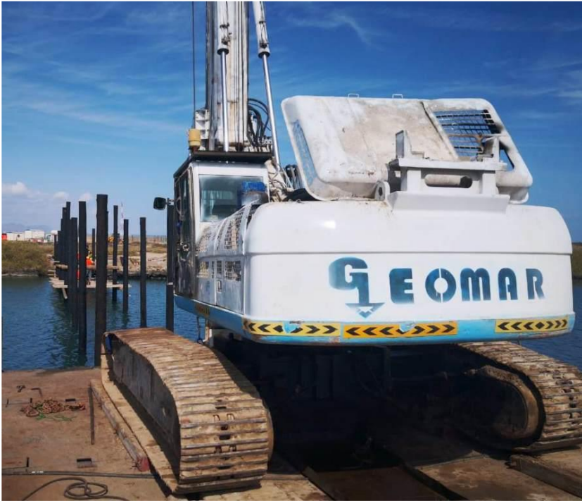
Soilmec R620 (2 No)
